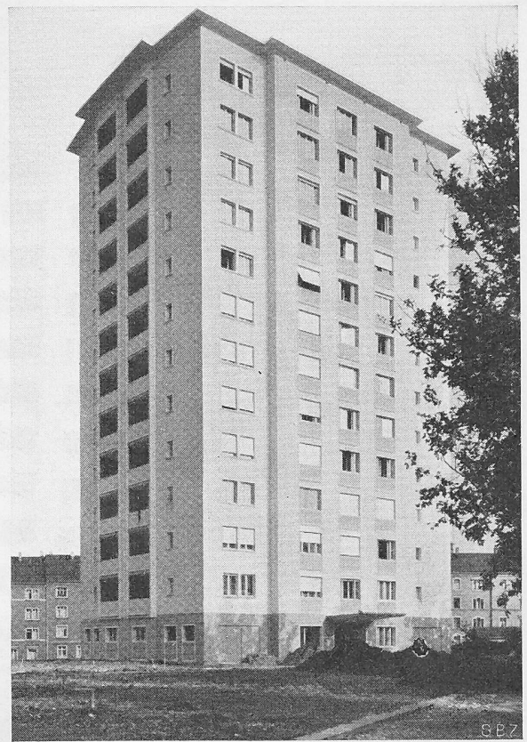
Bild 2. Ansicht aus Nordwesten
