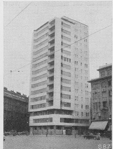
Bilder 18 bis 20. Wohnhochhaus (!) in Turin. Fehlende Freiflächen. Zusammenfassen der Fenster zu Bändern, wobei kleine Fensterchen für Küche und Bad im Fensterband untertauchen; sie sind mit breiten, blinden Rahmen cachiert worden. Früher malte man fehlende Fenster auf die Mauern
