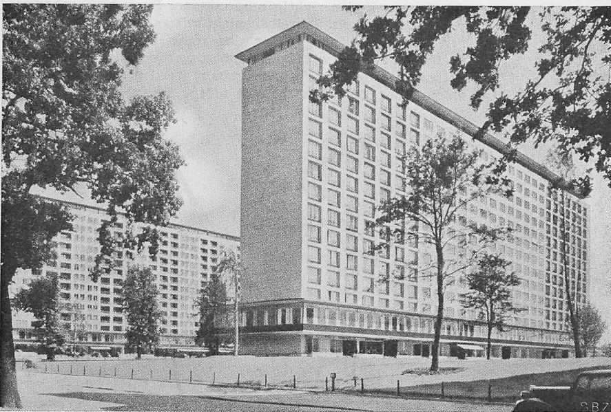
Bild 15. Wohnhochhäuser in Hamburg-Grindelberg
