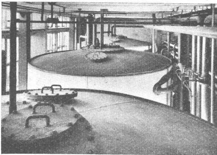
Reaktoren einer Speiswasseraufbereitungsanlage, Leistung 120 m<sup>3</sup>/h
