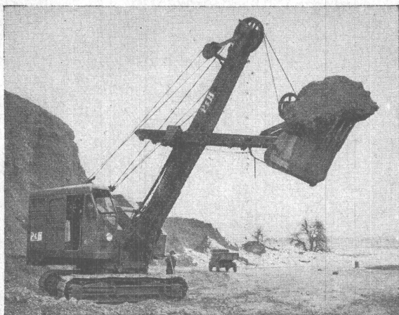
Löffelbagger mit Tru-Lay-Brugg-Drahtseilen ausgerüstet
