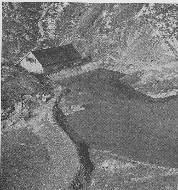
Bild 4. Das Pumpenhaus an der Saufila; im Vordergrund der Damm mit Zuleitung des Westarmes
