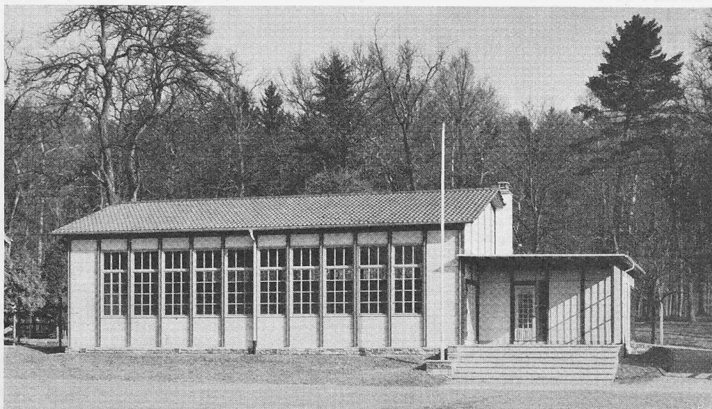
Bild 3. Sporthalle der Universität Bern, Durisol-Konstruktion mit Holzskelett, Architekt H. BEYELER, Bern
