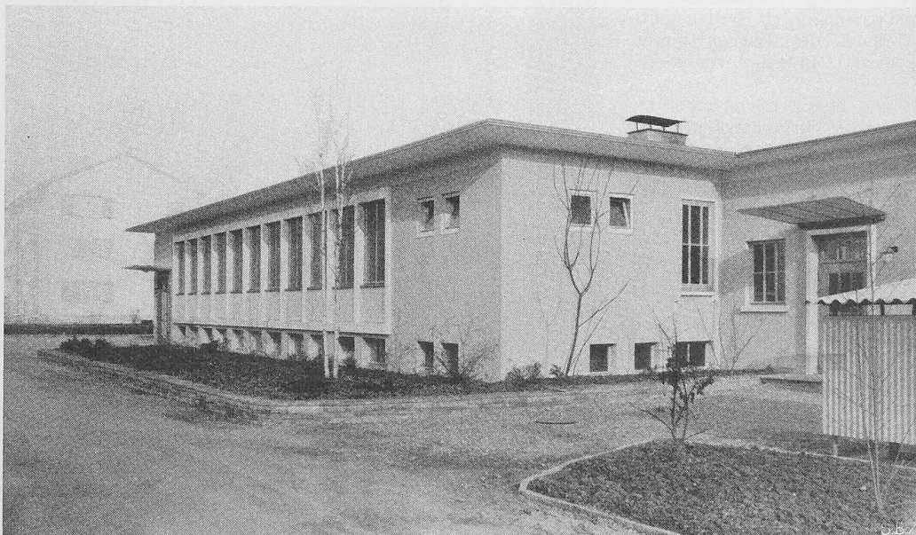
Bild 14. Bureaugebäude von Westen, rechts Eingang zur Werkstätte
