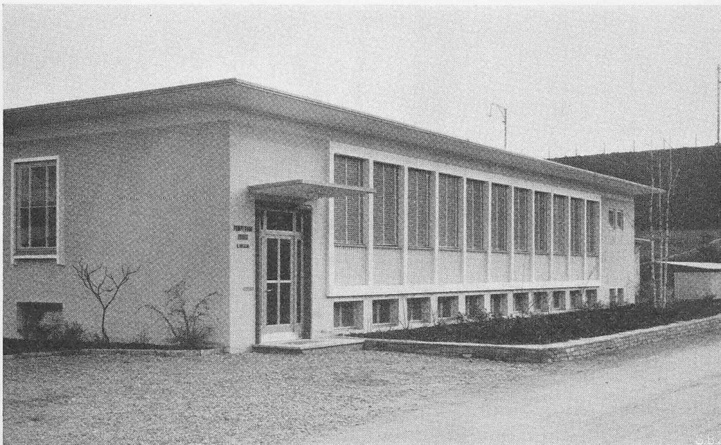
Bild 13. Eingang zum Bureaugebäude
