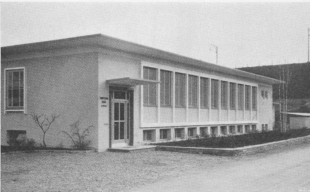
Bild 13. Eingang zum Bureaugebäude
