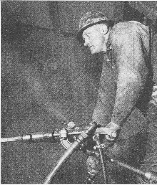
Bild 15. Bohren mit Bohrknecht, günstige, flache Stellung, Druck von oben («Tryckluft»)
