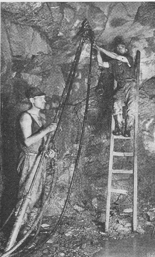
Bild 16. Bohrknecht mit grosser Verlängerung und grossem Stützwinkel (Photo Deutsche Kohlenbergbauleitung)
