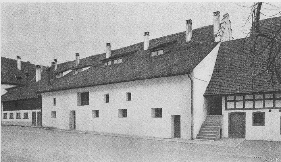
Westhof vor dem Umbau
