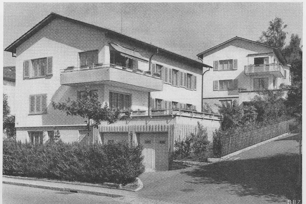
Mehrfamilienhaus Rotfluhstrasse 25, Ansicht aus Südwesten
