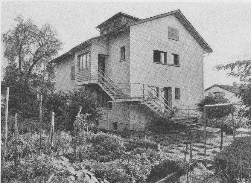
Ansicht der Aussentreppe Rotfluhstrasse 17
