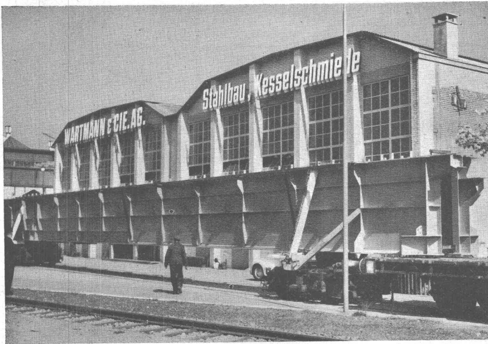
Geschweisste Träger für die neue Brücke der BLS bei Erlenbach
