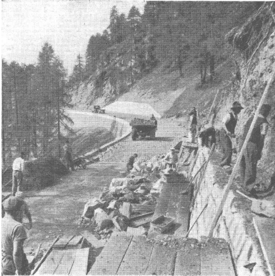
Verlegung der Julierstrasse in Marmorera
