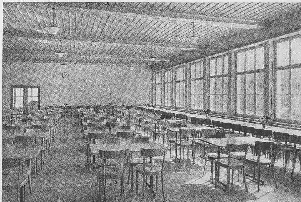
Bild 3. Arbeiterspeisesaal. Boden Klinker mit Streifen-teilung, Wände waschbar, Decke Tannenholz hell.
