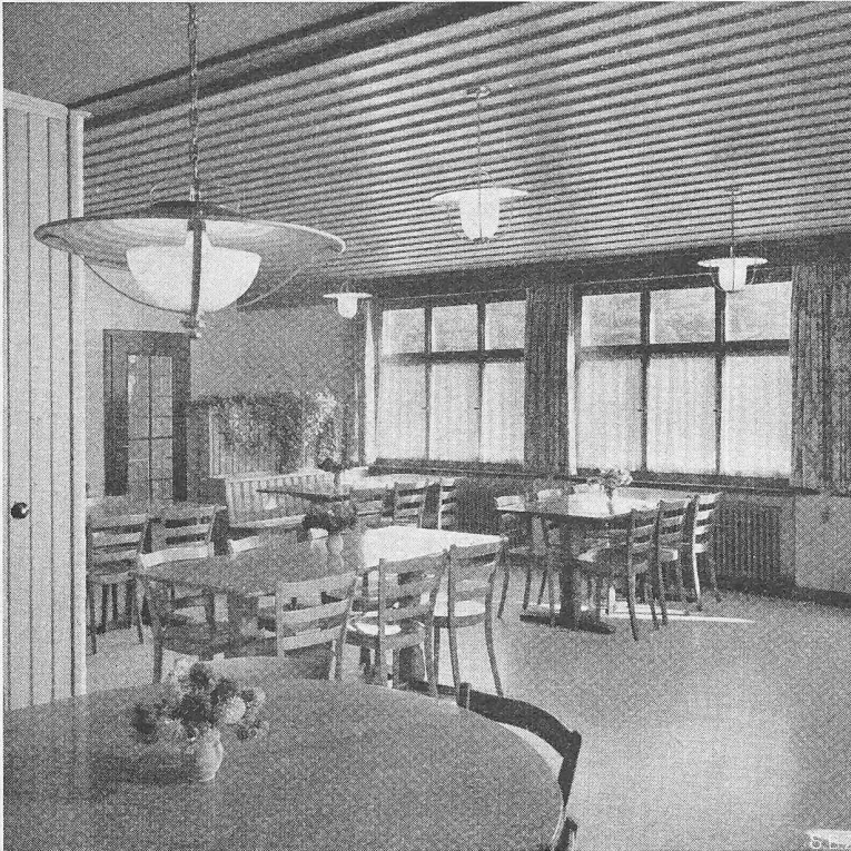
Bild 4. Angestelltenspeisesaal. Boden Plastokork, Wände Casolith-Putz, Decke Tannenholz hell gebeizt.
