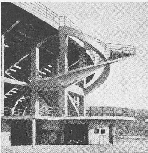
Bild 26 (links). Aufgangstreppe im Stadion von Florenz, freitragende Eisenbetonkonstruktion von grosser Eleganz. Unten Kassenschalter. Ing. P. L. NERVI (Photo Verfasser).
