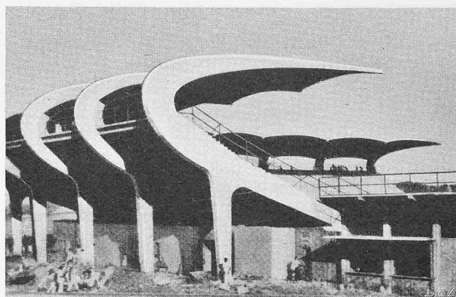
Bild 35. Tribüne des Baseballstadions in Cartagena (Columbien). Schalen zwischen Trägern ohne Stützen, vgl. Bild 6 [5].
