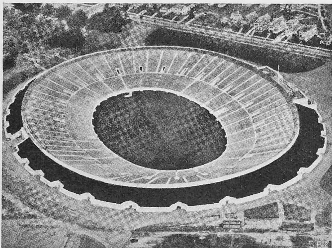
Bild 40. «Bowl-Stadion» der Yale-Universität bei New York. Zur Hälfte versenkt, zur Hälfte aufgeschüttet. Zugänge ebenerdig. Arch. DONN BARBER, Ing. C. A. VERRY [1].
