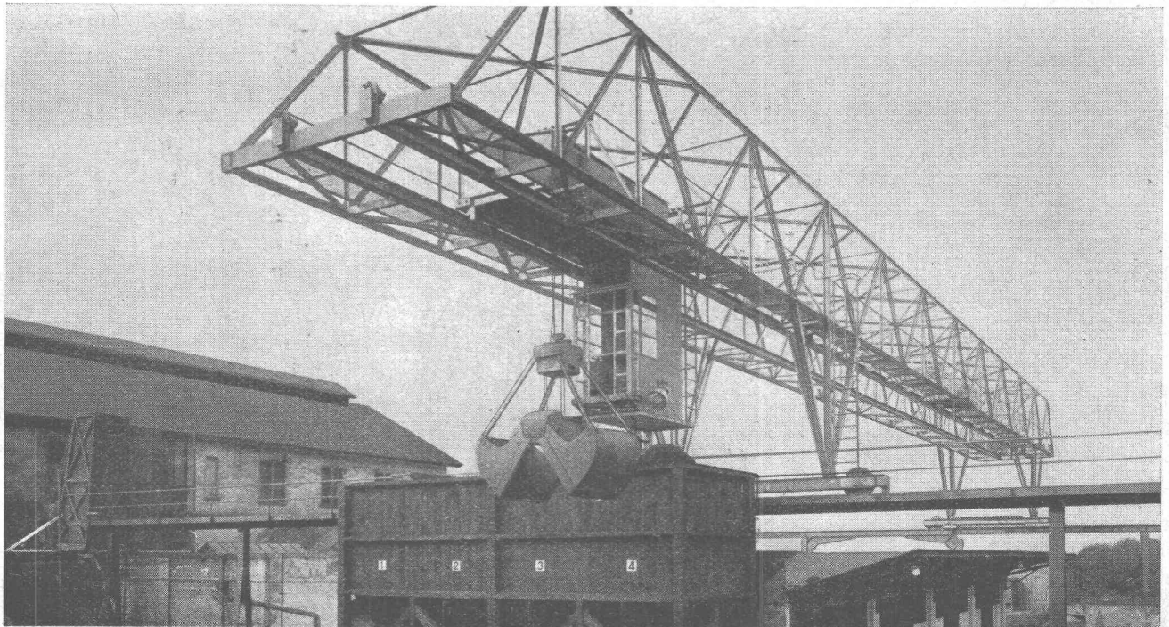
Verladebrücke in Schweisskonstruktion 2,5 t Tragkraft, 46 m Länge
