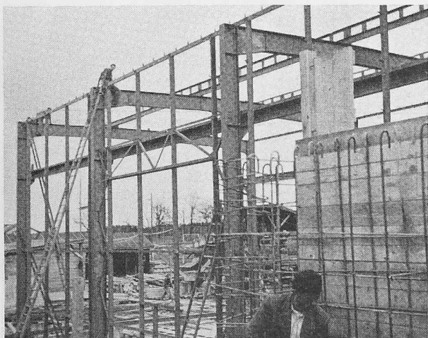
Bild 29. Montage der Werkstatt
