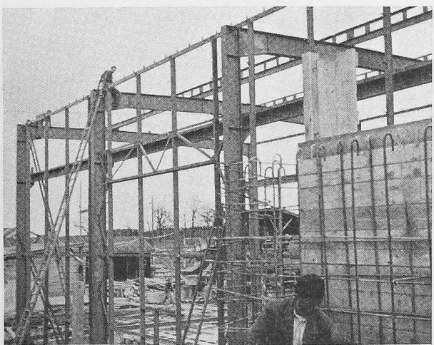
Bild 29. Montage der Werkstatt
