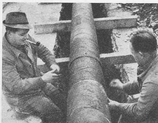
Bild 3. Die Stosstellen werden nach Verlegung zusammengeschweisst und mit «Vetrotex»-Band isoliert (Gaswerk Zürich)
