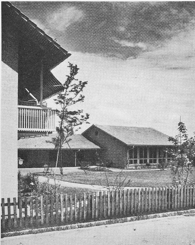
Bild 2. Nebenbau mit Tages- und Wirtschaftsräumen aus Südwesten
