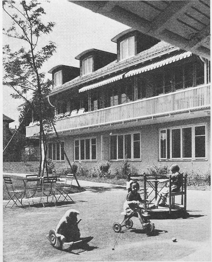
Bild 3. Hauptbau aus Nordosten
