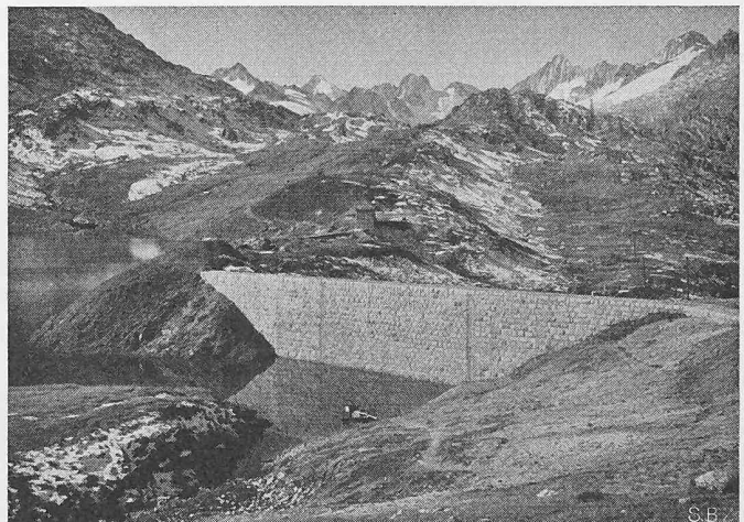
Bild 38. Staumauer Trübtensee, 20. Oktober 1949
