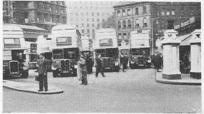
Bild 1. Ausgangsstation für acht Sadtlinien vor dem Victoria-Bahnhof, mit schärfster Ausnützung des vorhandenen Platzes (Bahnsteige knapp 1 m, Fahrbahnen 2,7 m breit)
