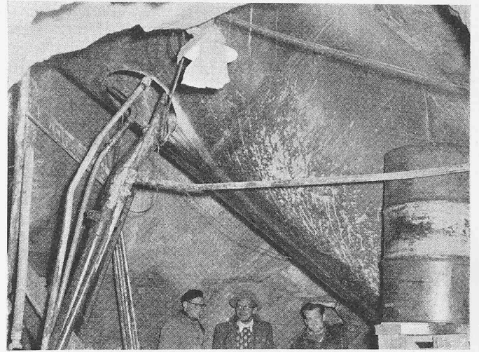
Fig. 4. Chambre d'injection à la cote 1040. Passage du blindage et trou d'homme
