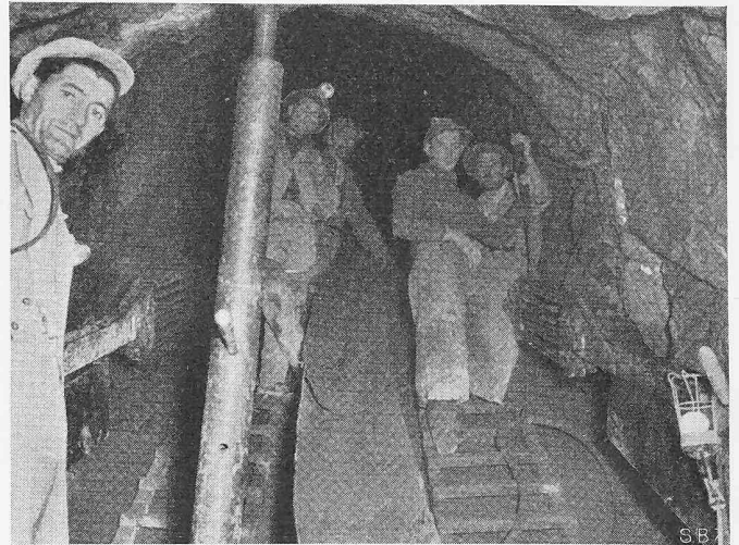
Fig. 9. Palans de déplacement du coffrage glissant
