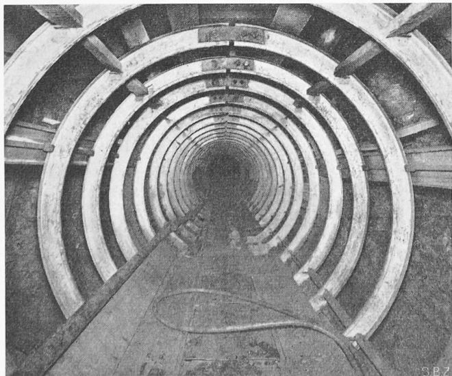
Bild 3. Montage der Murali an den fertig aufgestellten Spanten
