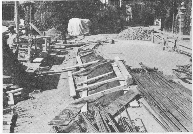
Bilder 1 und 2. Im ansteigenden Hang sollen mehrere Bauten erstellt werden; der Aushub für den untersten Trakt, als Hanganschnitt mit Bagger zuerst ausgeführt, löst lokale Abbrüche und tiefgreifende Hangrutschungen aus; eine einfache Fundation der andern Bauten wird unmöglich; die oberhalb liegende Strasse erleidet Risse und Setzungen. Ein ähnliches Bild bot eine Baugrube, deren Geschichte hier im Jahr 1949, Nr. 6, S. 84* geschildert wurde.
