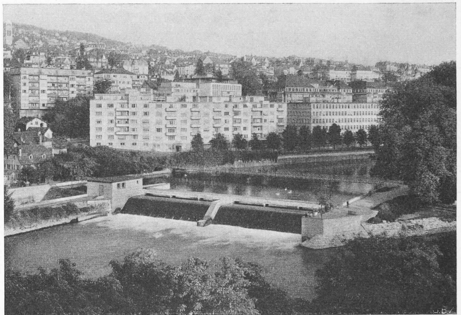
Bild 5. Hydraulische Dachwehranlage beim Platzspitz
