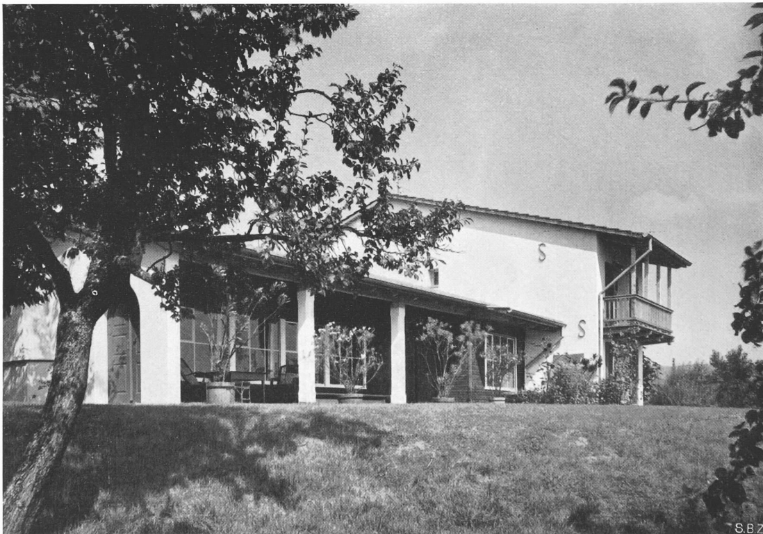
Bild 8. Ansicht von Südwesten
