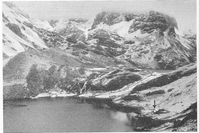
Bild 3. Die Speicher Pucro (Vordergrund) und Chiche, mit zusammen 4,3 Mio m 3 Nutzinhalt. Rechts von Pucro die Wärterhäuser mit der Radiostation
