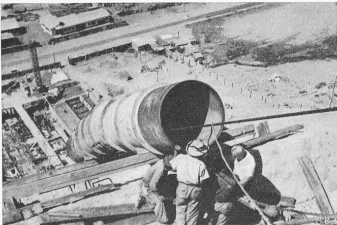
Bild 12. Druckleitungs montage
