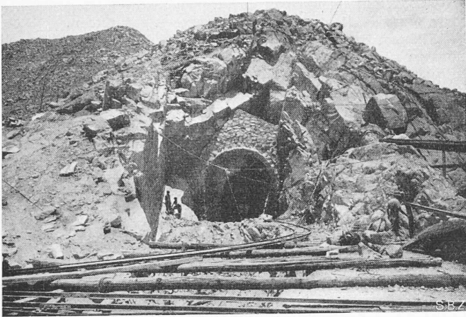
Bild 10. Stollenportal beim Wasserschloss
