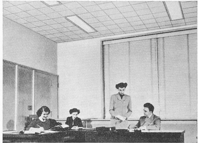
Bild 7. Bureauraum im ALCOA-Wolkenkratzer mit Frenger-Decke für Heizung im Winter und Kühlung im Sommer und mit versenkten Beleuchtungskörpern.
