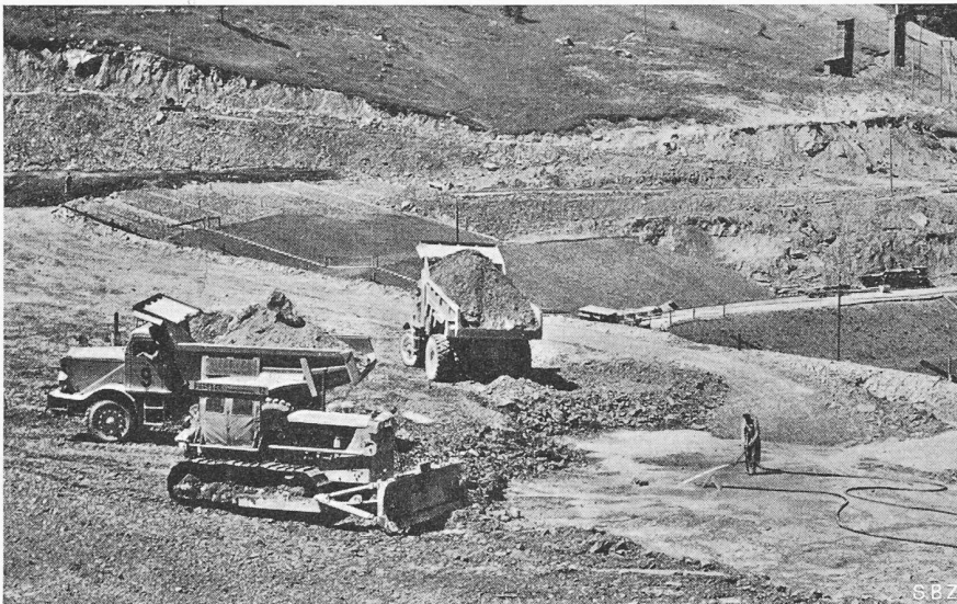
Bild 10. Aufbringen der Schüttung der Zone (3), Stützkörper.
