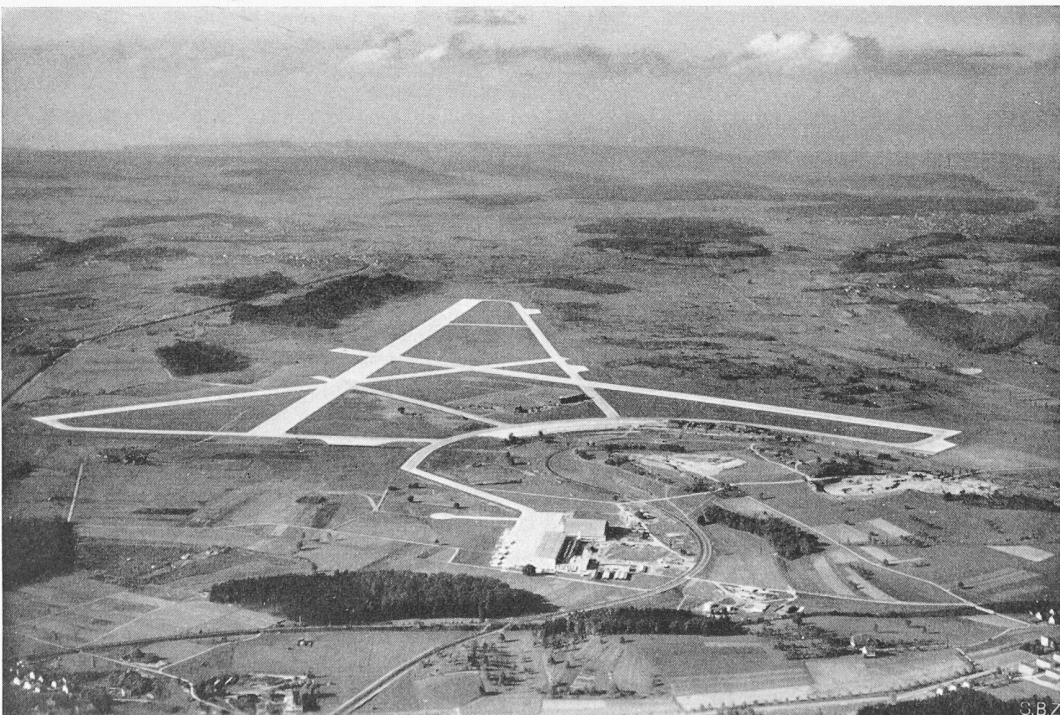
Bild 1. Flughafen Zürich-Kloten, gegen Norden gesehen, kurz nach der Vollendung der Tiefbauarbeiten im Oktober 1949 (Photo Swissair)
