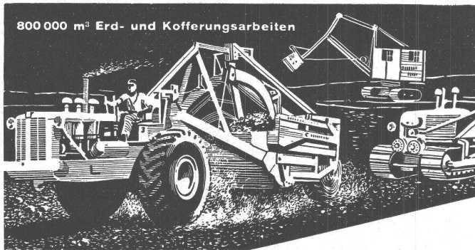
Bauunternehmungen If Flughafen Kloten
