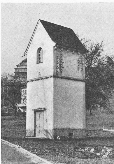
Bild 6. Station «Aegertli» in Thalwil. Giebeldachtyp, hervorgegangen aus Architektur-Wettbewerb der EKZ von 1909, verwendet bis Ende der zwanziger Jahre
