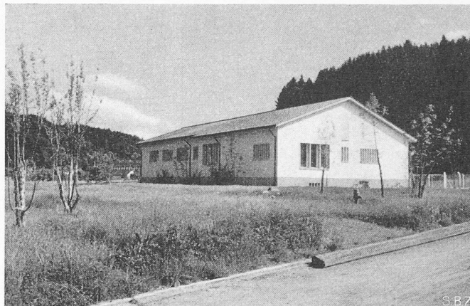
Bild 3. Das Unterwerk Saland (Baujahr 1951) im Tösstal, zwischen Saland und Blitterswil (siehe Bild 2)
