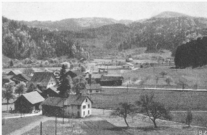
Bild 2. Das Unterwerk Saland von Westen, vorn Saland, im Hintergrund Blitterswil
