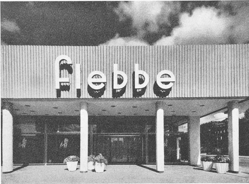
Bild 1. Geschäftshaus in Braunschweig, Behelfsdach durch Welleternit verborgen. Arch. F. W. KRAEMER
