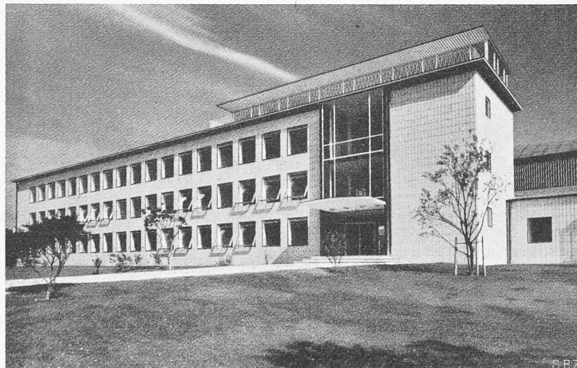
Bild 2. Rundfunkhaus des NWDR in Hannover. Architekten KRAEMER, LICHTENHAHN, OESTERLEN.
