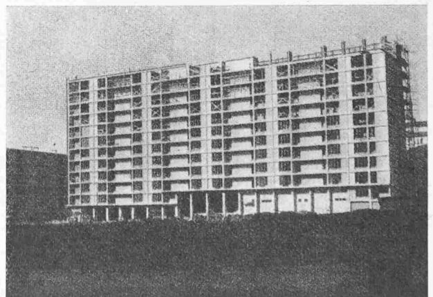
Bâtiment D à 13 étages, 15 décembre 1952
