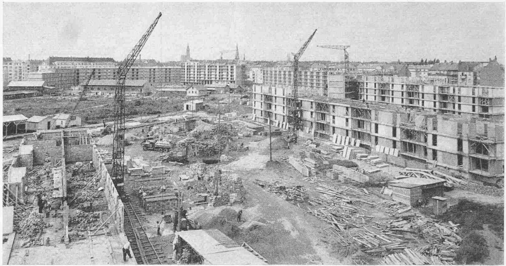
Vue du chantier, août 1952
