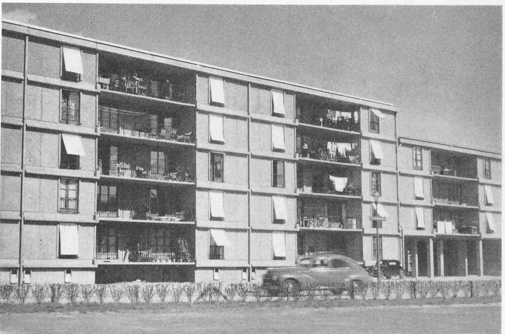
Façade principale d'un bâtiment à 4 étages, type V
