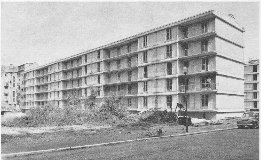
Vue d'un bâtiment à 4 étages, type VI
