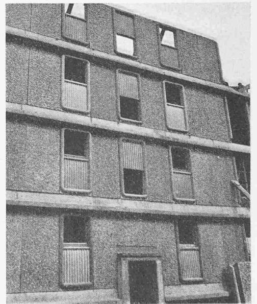
Détail des fenêtres
