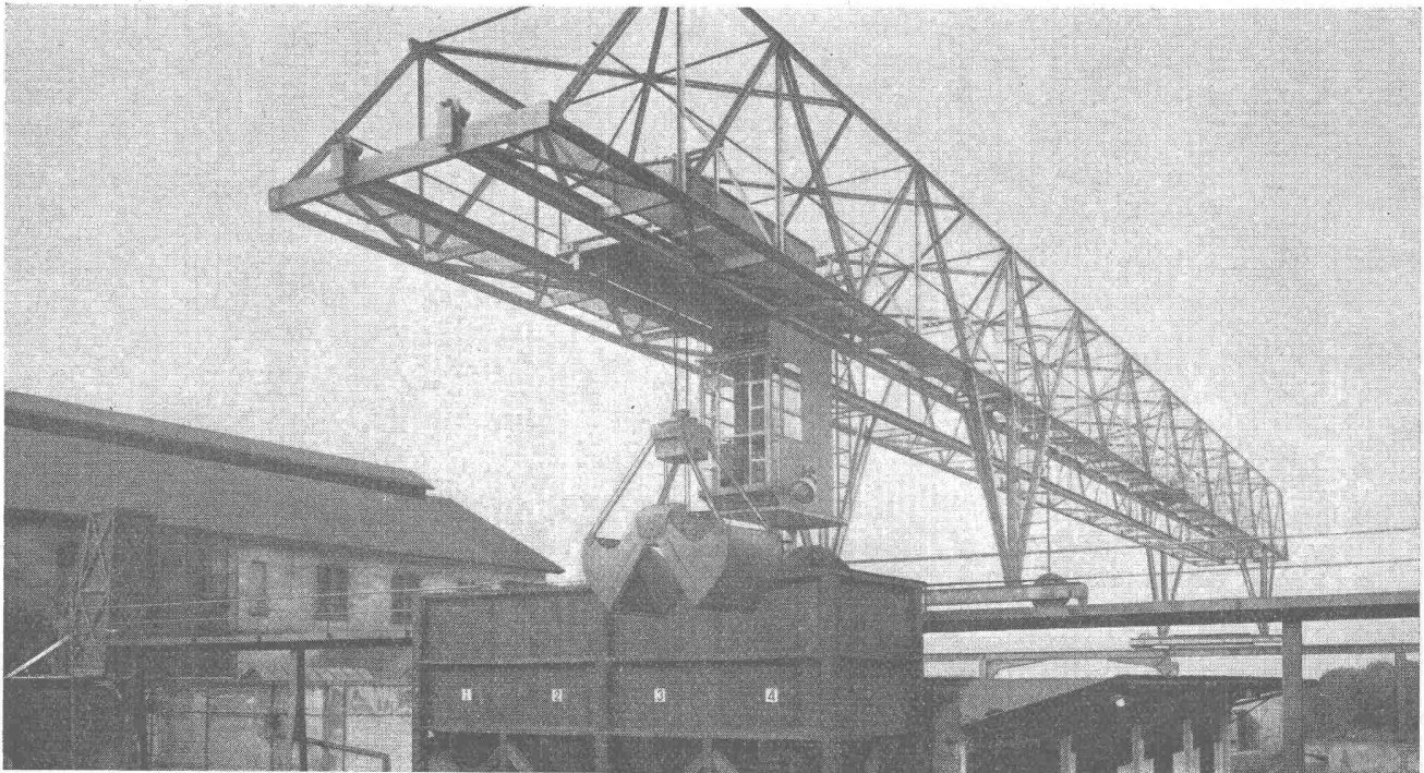
Verladebrücke in Schweisskonstruktion 2,5 t Tragkraft, 46 m Länge
