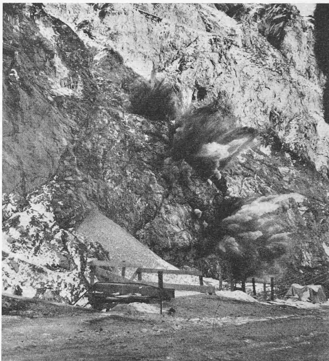
Bild 4. Grosssprengung.
