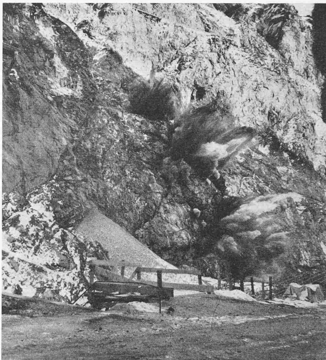
Bild 4. Grosssprengung.
