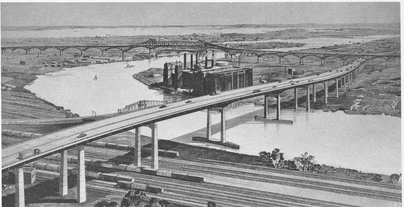
Bild 1. Brücke des New Jersey Turnpike (1951 erbaut) über den Passaic River; im Hintergrund der Pulasky Skyway (1926 erbaut)
