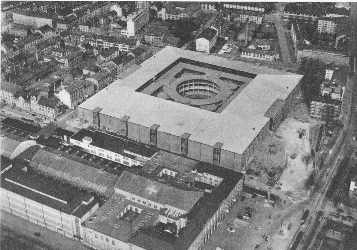
Bild 1. Fliegerbild aus Südwesten. Der Neubau von 400 000 m<sup>3</sup> bietet 50 000 m<sup>2</sup> Bodenfläche, wovon 20 000 m<sup>2</sup> Ausstellungsfläche und 30 000 m<sup>2</sup> Verkehrsflächen und Nebenraumfläche. Totale Baukosten 16 Mio Franken
