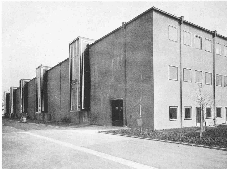
Fassade an der Istenerstrasse (links) und Hauptfassade (rechts)
