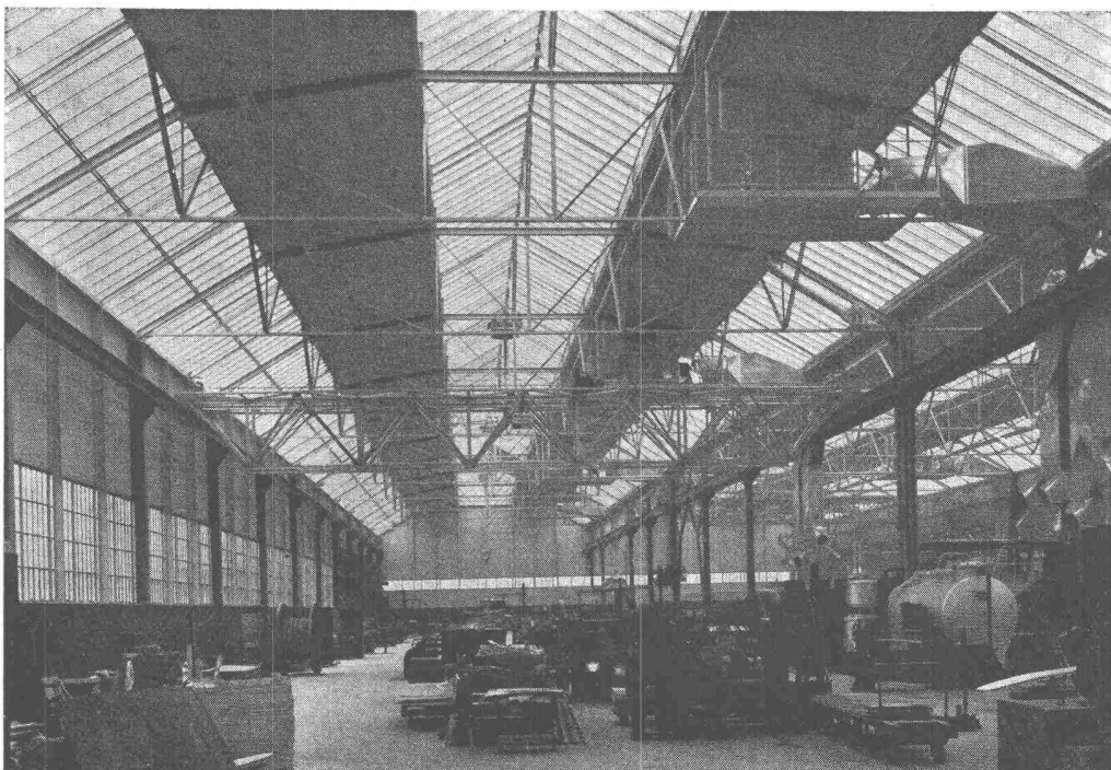
Produktionshalle, Krangerüst in Leichtmetall
