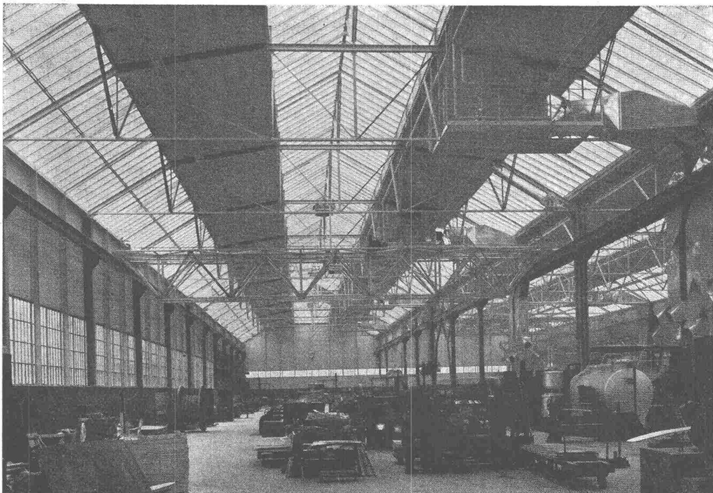
Produktionshalle, Krangerüst in Leichtmetall
