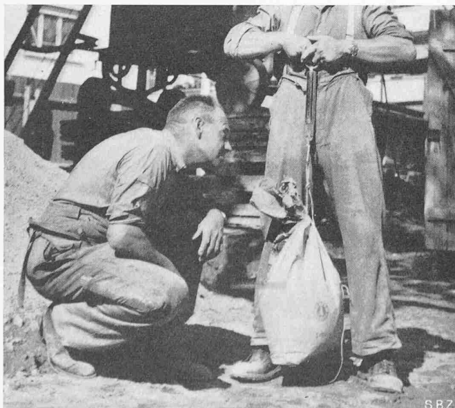
Bild 1. Wägen der Zementbeigabe mit Federwaage
