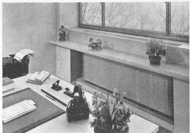
Bild 7. Einbau eines Jettair-Apparates in einem Bureauraum
