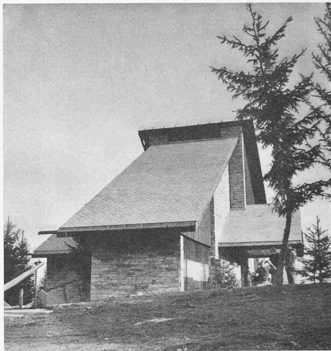
Fig. 12. Vista da nord-ovest
