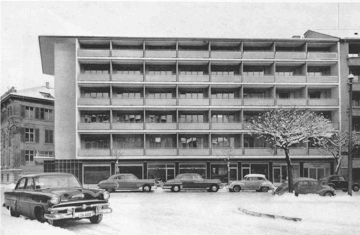
Ansicht von der General-Wille-Strasse
