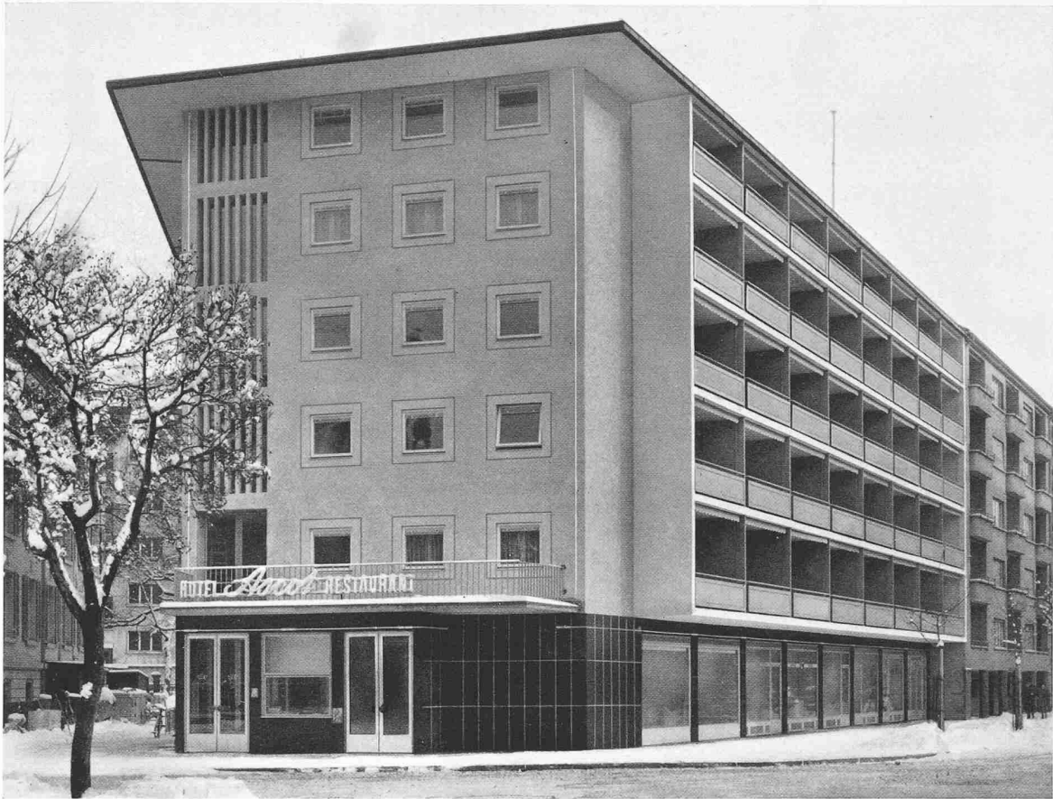
Ansicht von der Lavaterstrasse
