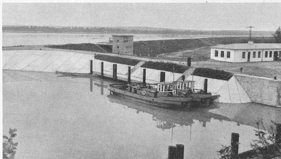
Bild 63. Pumpwerk und Hafen Seibersdorf
