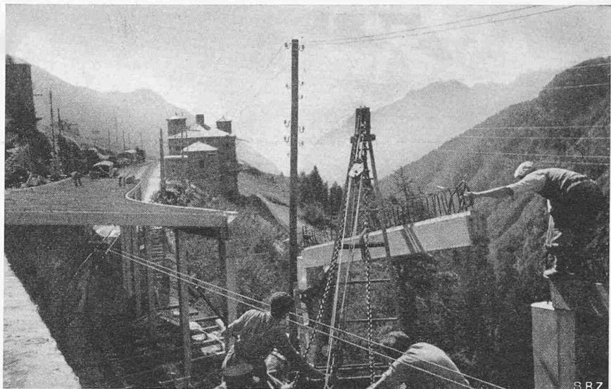
Bild 6. Versetzen eines Unterzuges
