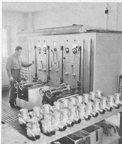
Fig. 11. Essais de compteurs à la station d'étalonnage
