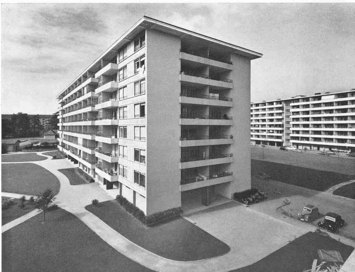
Bauten an der Rue du Vidollet
